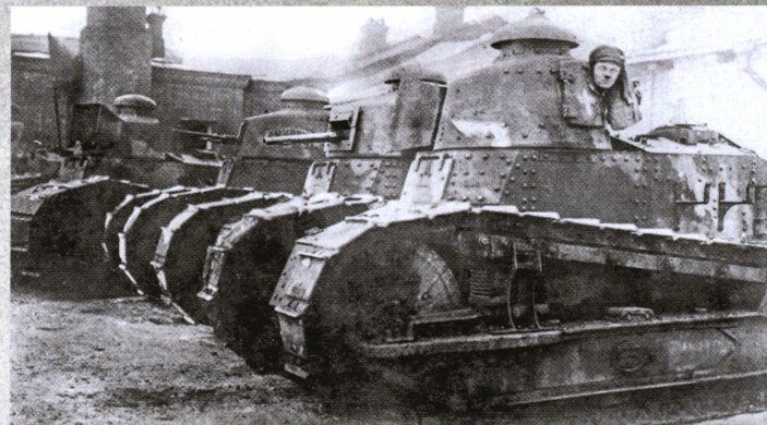
«Рено» FT 1-го Амурского тяжелого танкового дивизиона, 1920 год. Обратите внимание на броневые «короба», установленные на башнях для защиты пулеметов. Второй танк вооружен 37-мм японской пушкой, за ним видна машина с 8-мм пулеметом Гочкиса, на башне которой читается название «Амурец».
