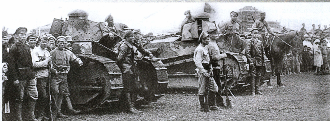
Танки 1-го Амурского тяжелого танкового дивизиона в Благовещенске, 10 августа 1920 года. Обратите внимание на броневые «щеки» на башне дальней машины, вооруженной пулеметом Максима.
